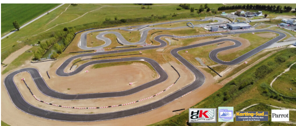
Circuit Haute-Garonne Karting de Muret (31)
